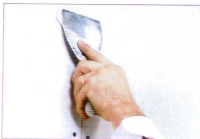
Emasse generosamente o rebaixo entre as placas (1ª camada de colagem da fita).
